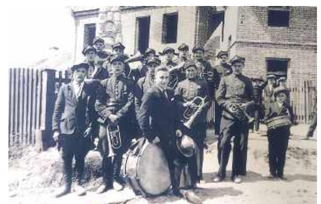
Orkiestra Dęta z Biszczu na tle budowy budynku Urzędu Gminy
