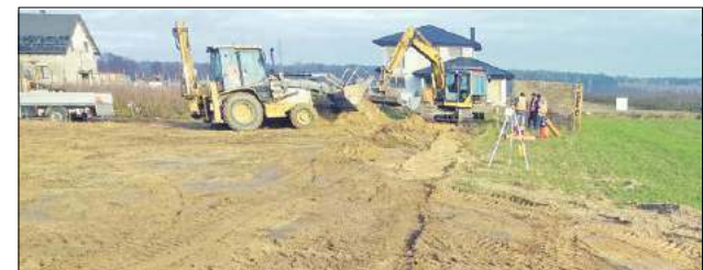
W trakcie realizacji jest przedsięwzięcie związane z gospodarką wodno-ściekową, obejmujące modernizację oczyszczalni
