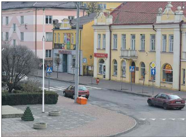
W planach jest modernizacja ul. Warszawskiej od dzwonnicy do tzw. grzybka
