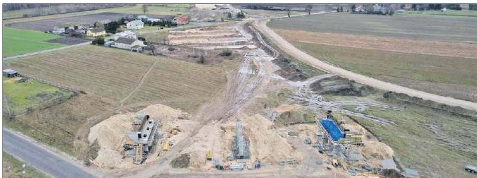
Wykonawcą odcinka Swory – w. Biała Podlaska jest firma Polaqua. Zakończenie inwestycji planowane jest w czwartym kwartale 2024 r.
