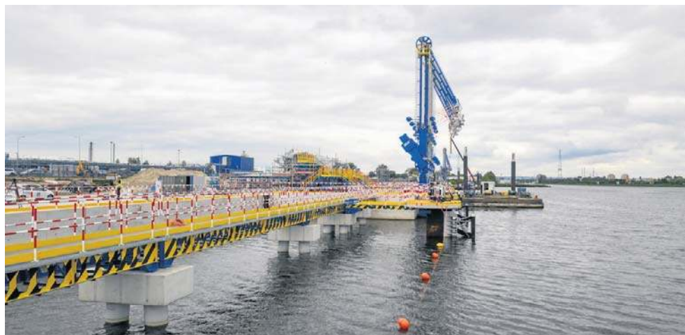
Nabrzeże terminalu ma długość 380 metrów. Wraz z pogłębionym torem wodnym umożliwi przyjmowanie statków o nośności 10 tys. ton
