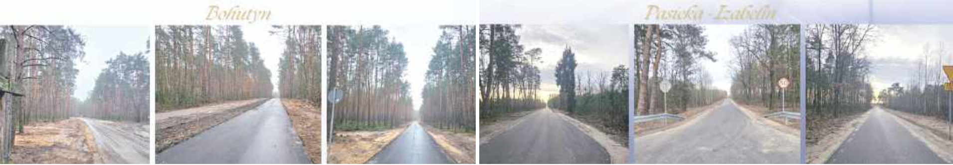
W gminie Sosnowica powstały dwie drogi
