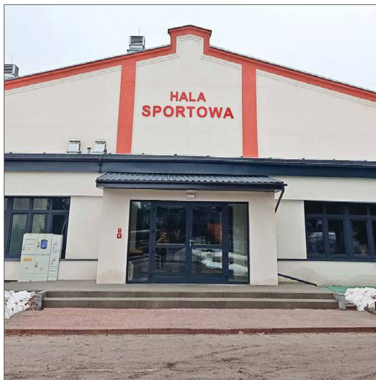
Hala przy Kościuszki po wielu miesiącach remontu już funkcjonuje.
