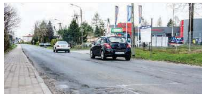
– Mam świadomość, że wielu z markłowicz, ale również osób korzystających z ul. Wyzwolenia, denerwuje się podróżując nią – przyznaje nam wójt Tadeusz Chrószcz. W przyszłym roku ma ruszyć remont drogi.
