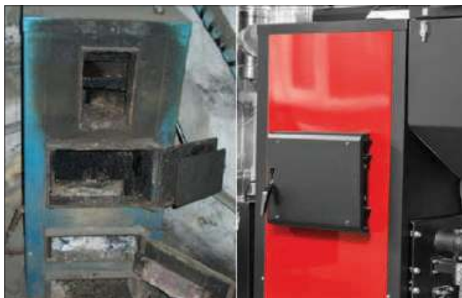
Kopciuchy przez wiele lat najchętniej były wymieniane przez właścicieli domów jednorodzinnych właśnie na nowoczesne kotły węglowe. Od 2022 zniknie możliwość pozyskiwania na taką wymianę dotacji wsparcia finansowego z programu „Czyste powietrze”.
