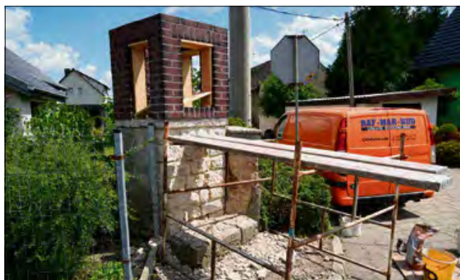
Na razie trwają zaawansowane prace budowlane.
