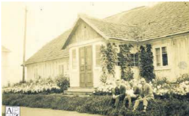
Jeden z budynków, który stał kiedyś na terenie zamojskiej szkoły rolniczej. Mieszkał tam dyrektor Stefan Bauer . Fotografie przekazał do APZ Andrzej Bauer .
