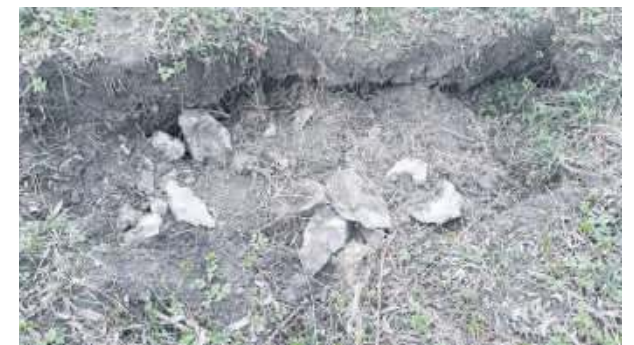
Sklepienie jednej z nor załamało się pod ciężarem samochodu. Foto: MP
