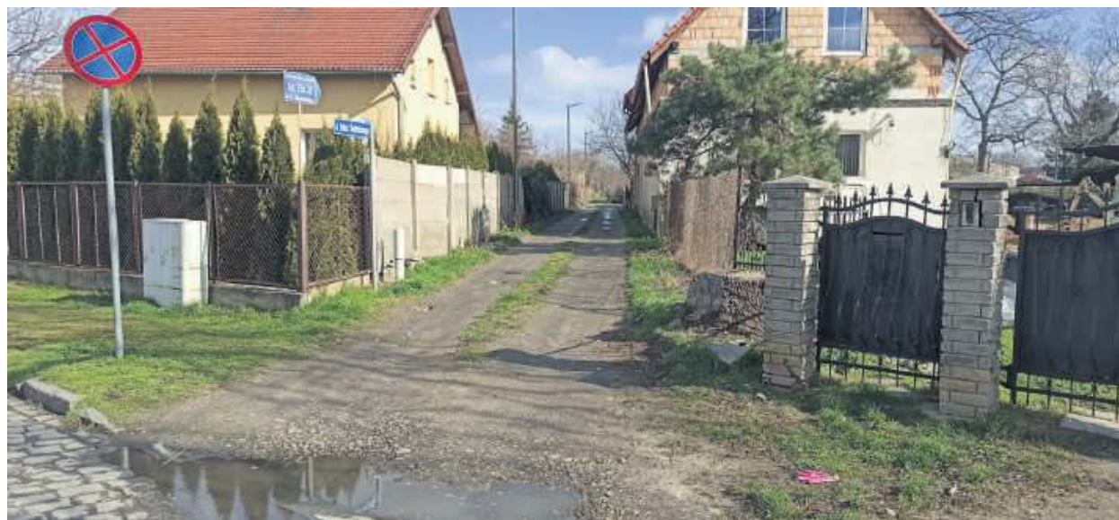
Radni przekazali pieniądze na remont łącznika na ul. Bolka I Świdnickiego w Strzelinie
