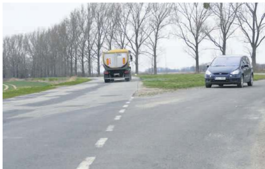
Wójt Andrzej Łuczak poinformował radnych, że odbył się przetarg otwarty na remont kolejnego odcinka drogi powiatowej ze Strzelina w stronę Jegłowej, aż do zakrętu przed tą miejscowością, gdzie znajduje się parking
