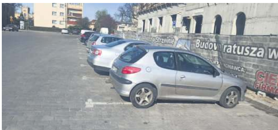
Miejsca parkingowe, które przylegają do placu budowy ratusza, zostaną zlikwidowane
