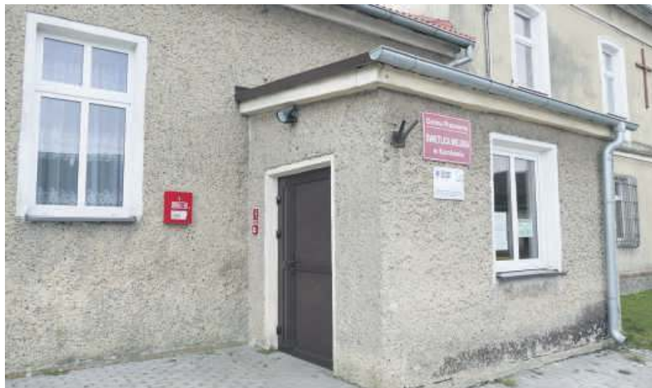
Remont świetlicy wiejskiej w Karnkowie będzie kosztował ponad 70 tysięcy złotych
