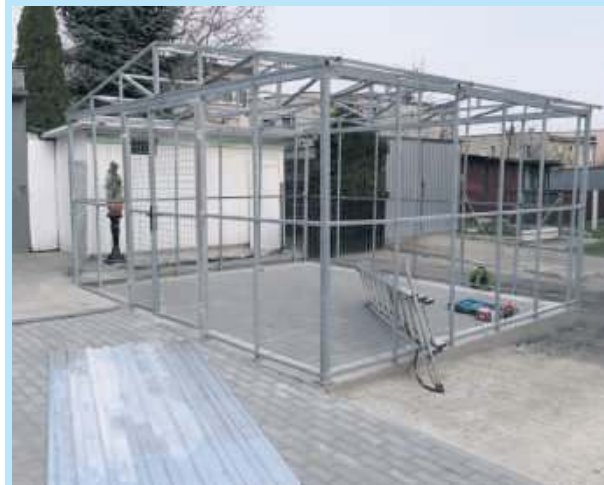
Mieszkańcy budynku socjalnego przy ulicy M. Konopnickiej w Strzelinie doczekali się wiaty śmietnikowej, która z pewnością pomoże utrzymać porządek na podwórku – w poniedziałek trwały prace związane z montażem stalowej konstrukcji
