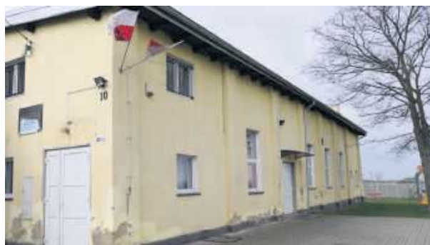
Gmina Wiązów otrzymała pół miliona złotych dofinansowania na remont świetlicy wiejskiej w Wyszonowicach
