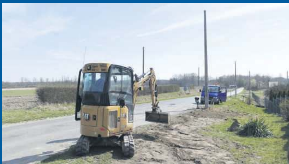
Montaż dodatkowych lamp ulicznych w Jegłowej
