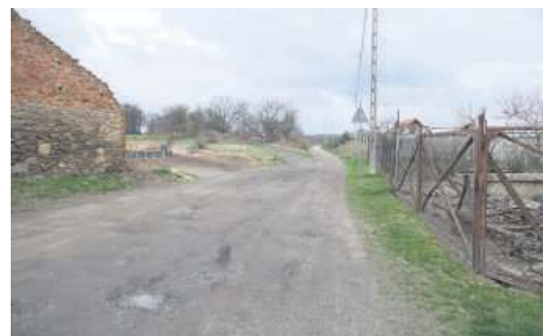
Remont drogi gminnej w Wyszonowicach zacznie się na skrzyżowaniu w centrum wsi, naprzeciwko granitowego krzyża, a przy warsztacie samochodowym
