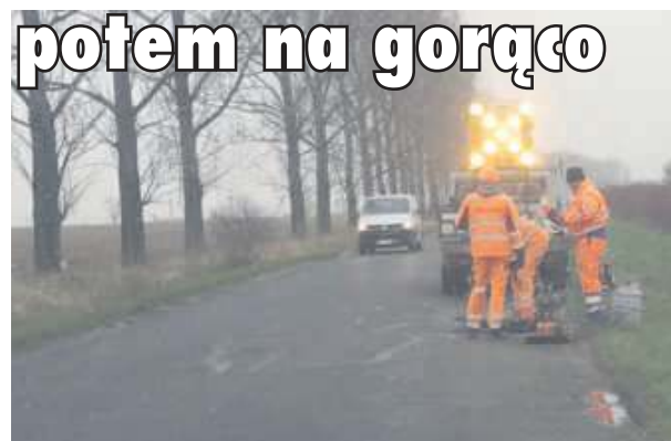
Łatanie dziur masą na zimno wykonali pracownicy Powiatowego Zarządu Dróg w Strzelinie. Zdjęcie zrobione na odcinku Strzelin-Jegłowa
