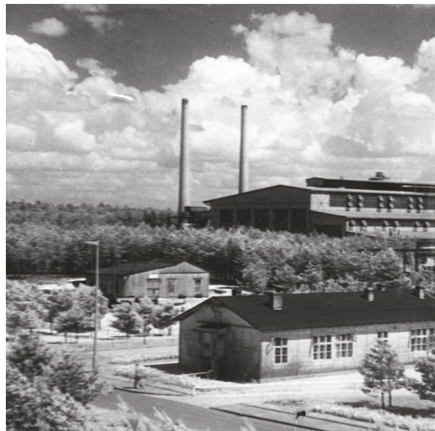
Stalowa Wola Zakłady Południowe
