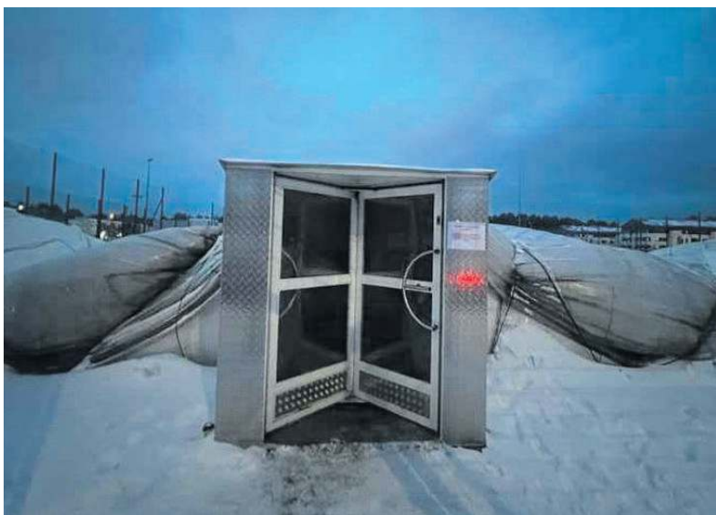
Tak wyglądało wejście do hali w niedzielę
