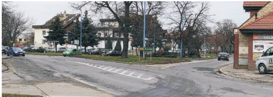
W ramach remontu kolejnego odcinka ul. Wolności w Strzelinie planowana jest przebudowa skrzyżowania u zbiegu ulic Wolności, Oławskiej i Wrocławskiej
