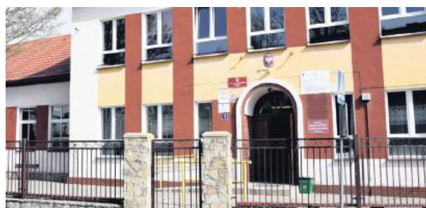
Budynek Szkoły Podstawowej w Prusach ma przejść termomodernizację. Wójt Tomasz Gracz planuje także wymianę źródła ogrzewania
