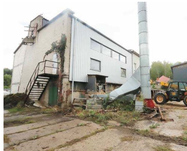
Kotłownia w Słupach
