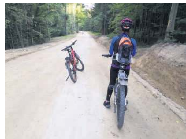
Kilka kilometrów odremontowanej drogi pod Gromnikiem robi duże wrażenie
