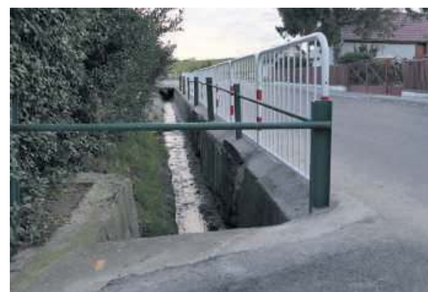
Nowe barierki zostały zamontowane, mimo że nie usunięto starych. Czy mieszkańcy mogą się czuć podwójnie bezpieczni w tym miejscu?
