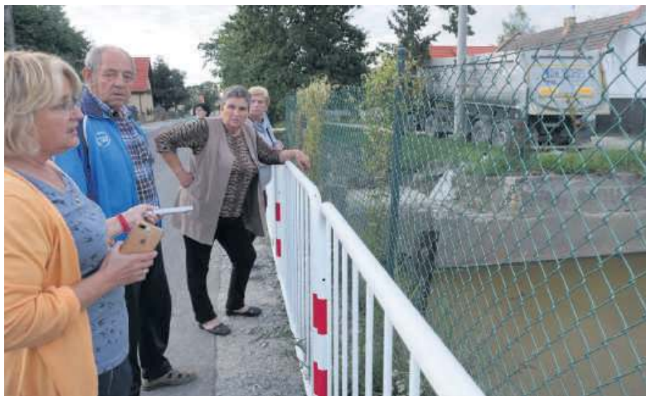
Kolejna nowatorska myśl techniczna – barierki chronią siatkę odgradzającą staw
