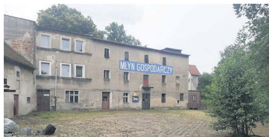
Remont tego budynku pochłonie od półtora do dwóch milionów złotych. Obecnie w środku i na zewnątrz trwają prace porządkowe
