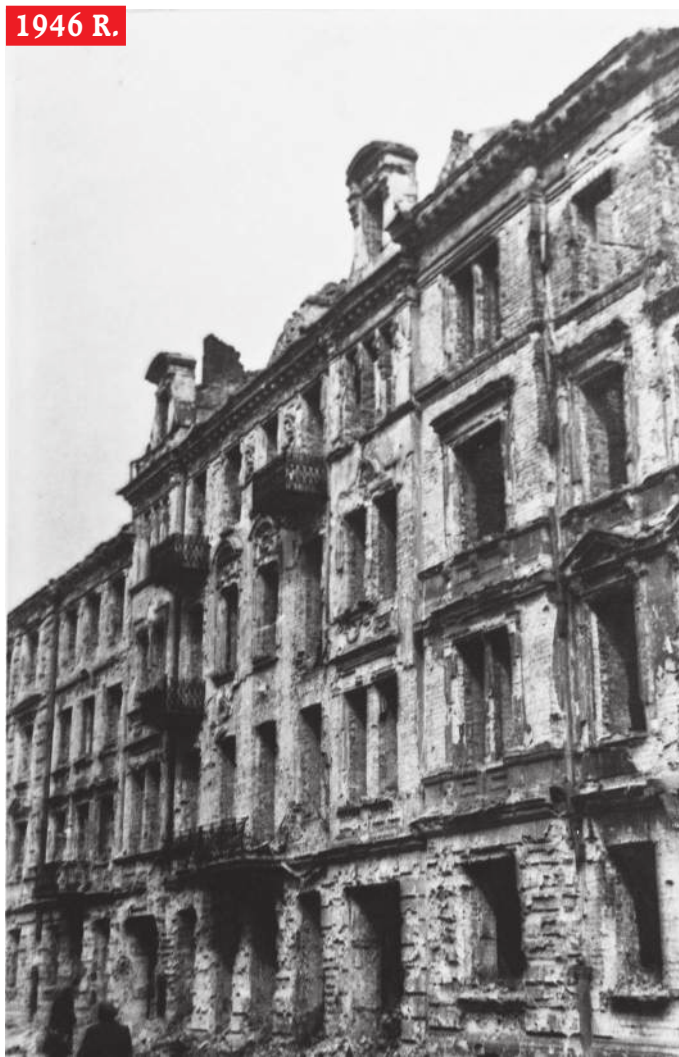
Kamienica przy ul. Ciepłej 28 wraz z sąsiednimi domami. Odcinek przed skrzyżowaniem z Krochmalną. Stan z 1946 r. Akta BOS. Zbiory Archiwum Państwowego w Warszawie | fot. Tomasz Hamrat/Gazeta Polska
