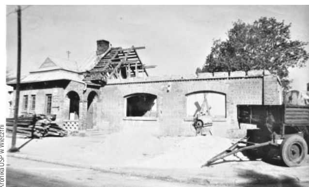
Rozbudowa remizy w Wieczfni, w latach 1988-1989.
