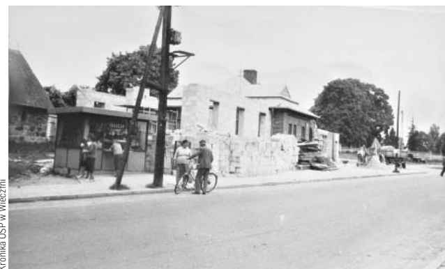
Rozbudowa remizy w Wieczfni, w latach 1988-1989.
