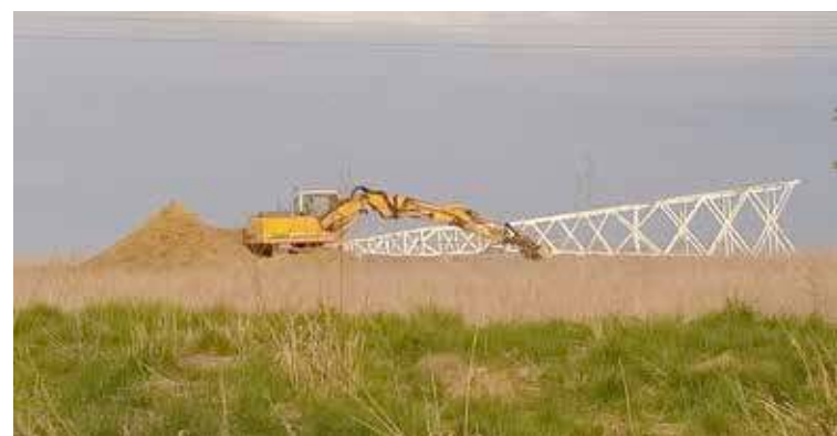
Prace na odcinku pomiędzy Nowogardem a Olchowem rozpoczęły się ok. 3 miesiące temu
