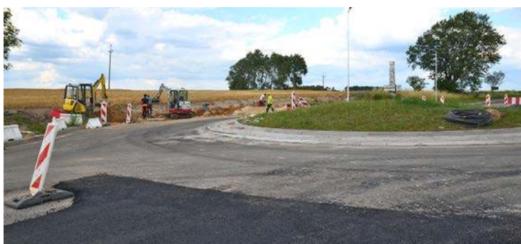
Prace przy przełączaniu kabla trwały we wtorek do późnych godzin popołudniowych.
