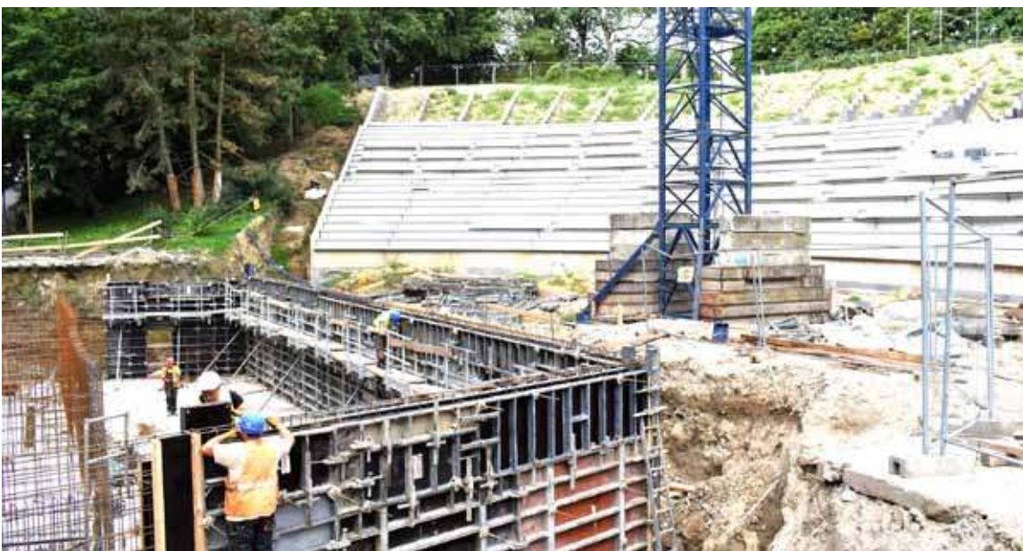
Jeśli obecne tempo realizacji inwestycji nie napotka przeszkód, amfiteatr ma być gotowy w połowie 2024 r.
