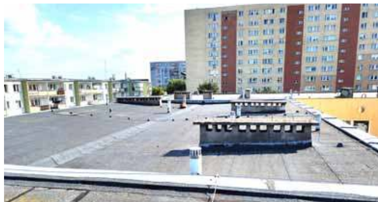
W ramach prac na dachu wykonawca m.in. oczyści podłogę, naprawi drobne fragmenty pokrycia i uszczelni różne wystające elementy
