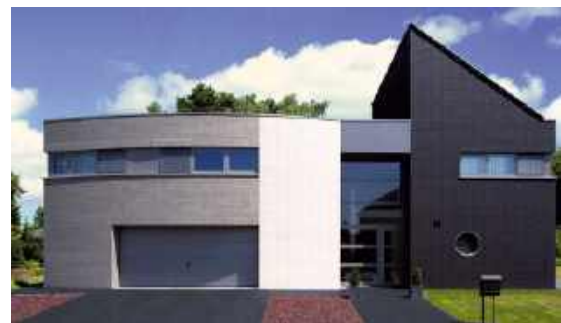
Elewacja budynku wykonana z cegły klinkierowej w odcieniach szarości i czerni. RÖBEN
