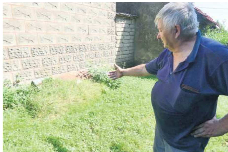
W tym miejscu ułożone były kiedyś worki, które chroniły budynek przed zalaniem. Dziś jest to górką piasku
