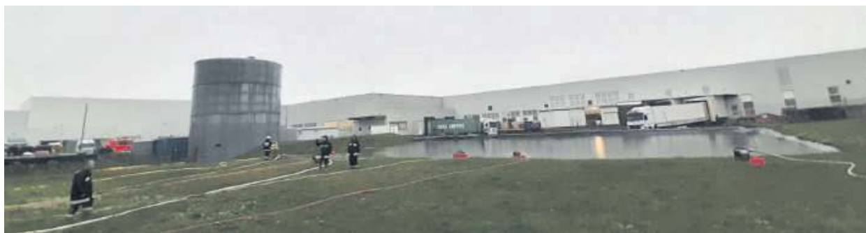
Przerwanie zbiornika p-poż groziło zalaniem hal produkcyjnych i okolicznych domów. Foto: dokumentacja OSP Wiązów
