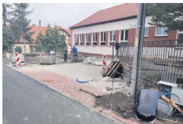
Przed szkołą w Prusach powstaje wyniesione przejście i zatoka autobusowa
