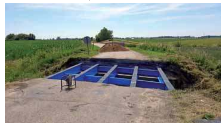
Przebudowa mostu w Grabowie potrwa do połowy wakacji
