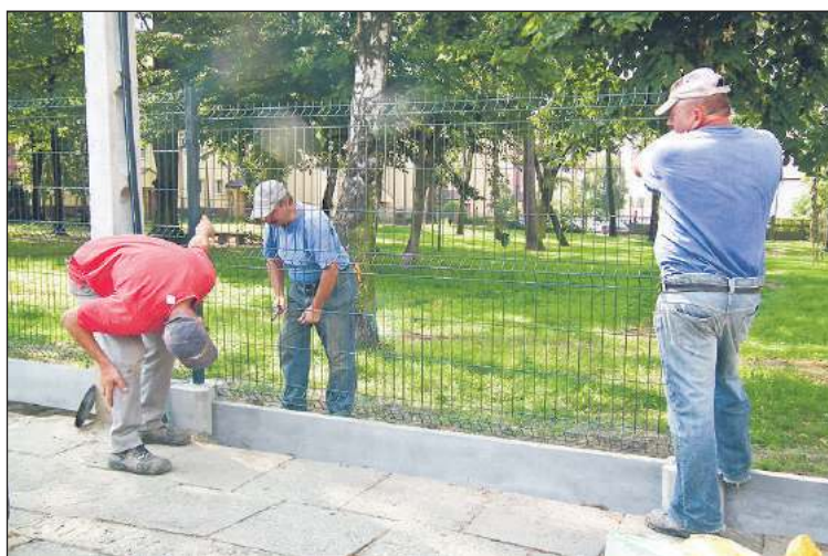
Ogrodzenie wymienione zostało w zeszłym roku.
