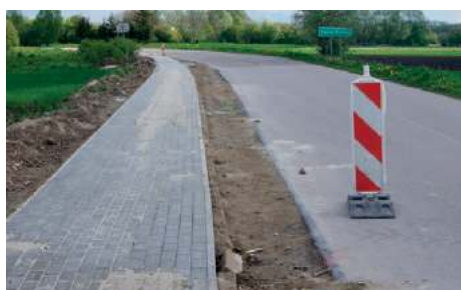
Modernizacja drogi w Kamieniu Kolonii
