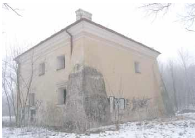
Lamus na początku drogi wiele lat temu
