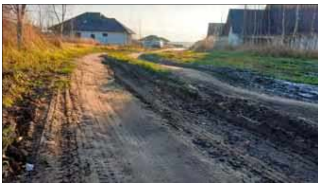
Taki widok ulic osiedlowych niedługo odejdzie w przeszłość.
