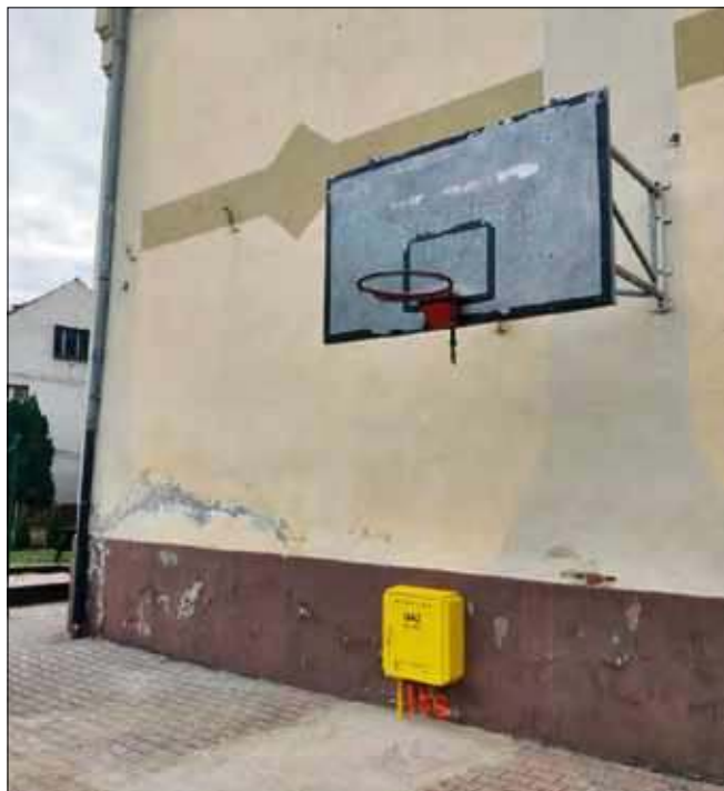
Skrzynka została zamontowana prawie na środku boiska.
