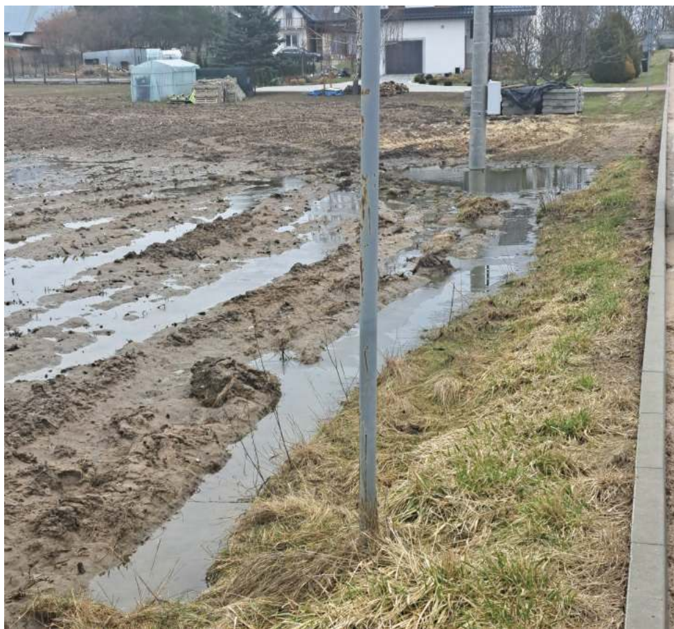
Woda zalewa asfalt i sąsiednią działkę prywatną. Teraz przez wiele dni na jezdni była ogromna kałuża
