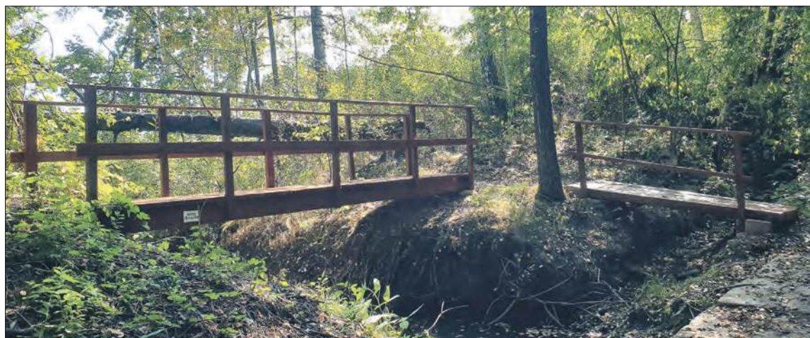
Nowe mostki na Dębowieckim Potoku
