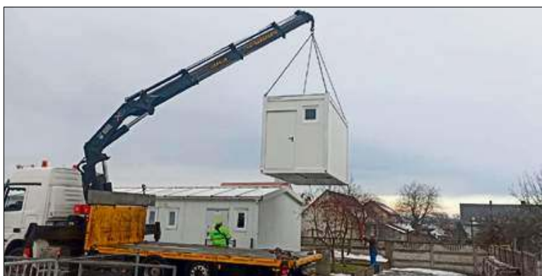
Kontener zamontowano w piątek 23 grudnia.
