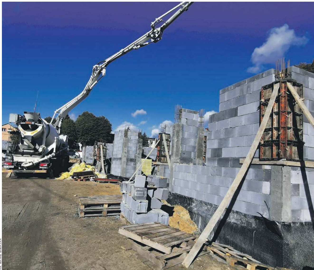
Trwa budowa pawilonów handlowych na placu Mogielnickiego w Babicach
