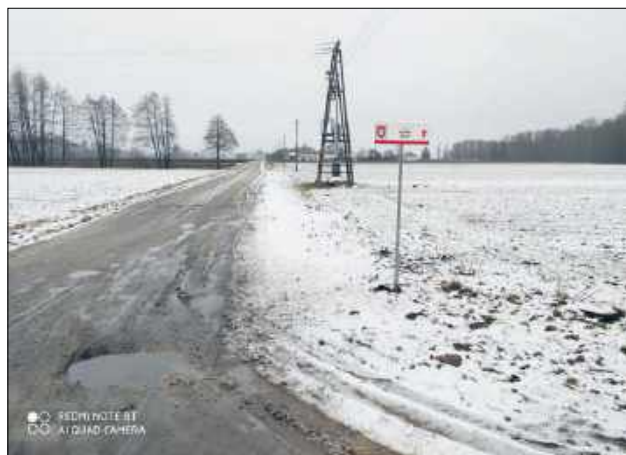
Remontowanych będzie pięć odcinków dróg, za kwotę 9 mln zł, w tym ul. Nowa w Drełowie
