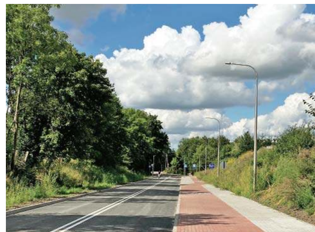
Ulica Dąbrowskiego o dł. 1,5 km przeszła gruntowny remont
