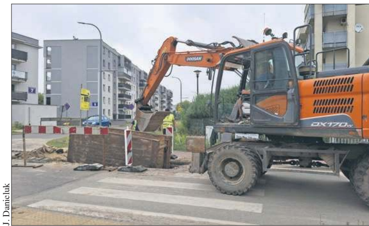
Początek prac na ul. Maneżowej
