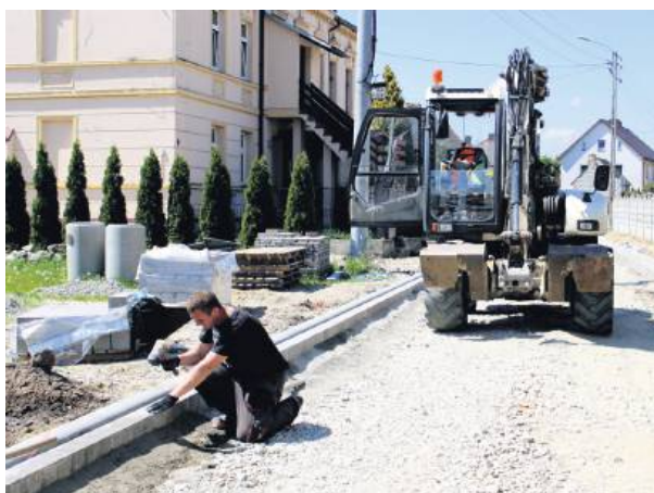
Trwa remont ul. Szkolnej i ul. Floriana w Borku Strzelińskim. Foto. UG Borów
