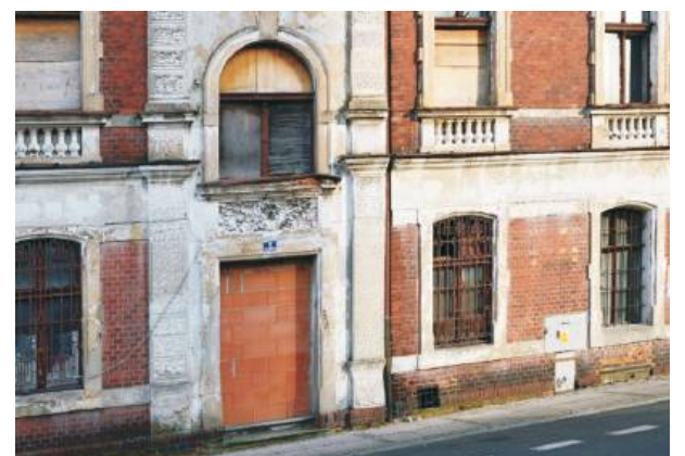
Właścicielem dawnej gorzelni w Przewornie jest Śląsk Agencja Faktoringowa S.A. z siedzibą w Raciborzu. Wejście do budynku spółki jest od dawna zamurowane, a okna zabite deskami. Foto: Danuta Kazimierska, Fotopolska.ue
