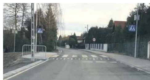
Wyremontowana ul. Miękińska w Krzeszowicach
