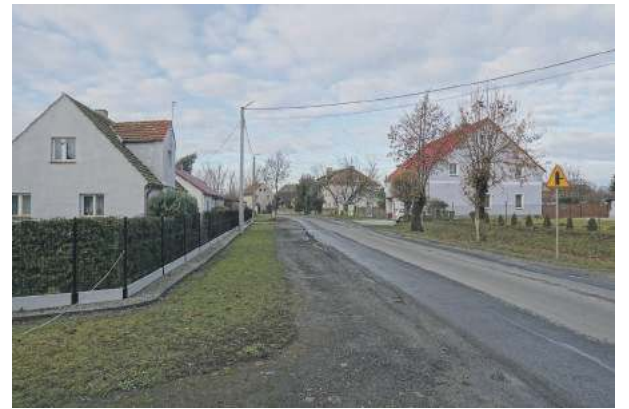
Gmina Strzelin przeznaczy prawie 241 tys. zł na remont chodnika przy drodze powiatowej w Bierzynie
