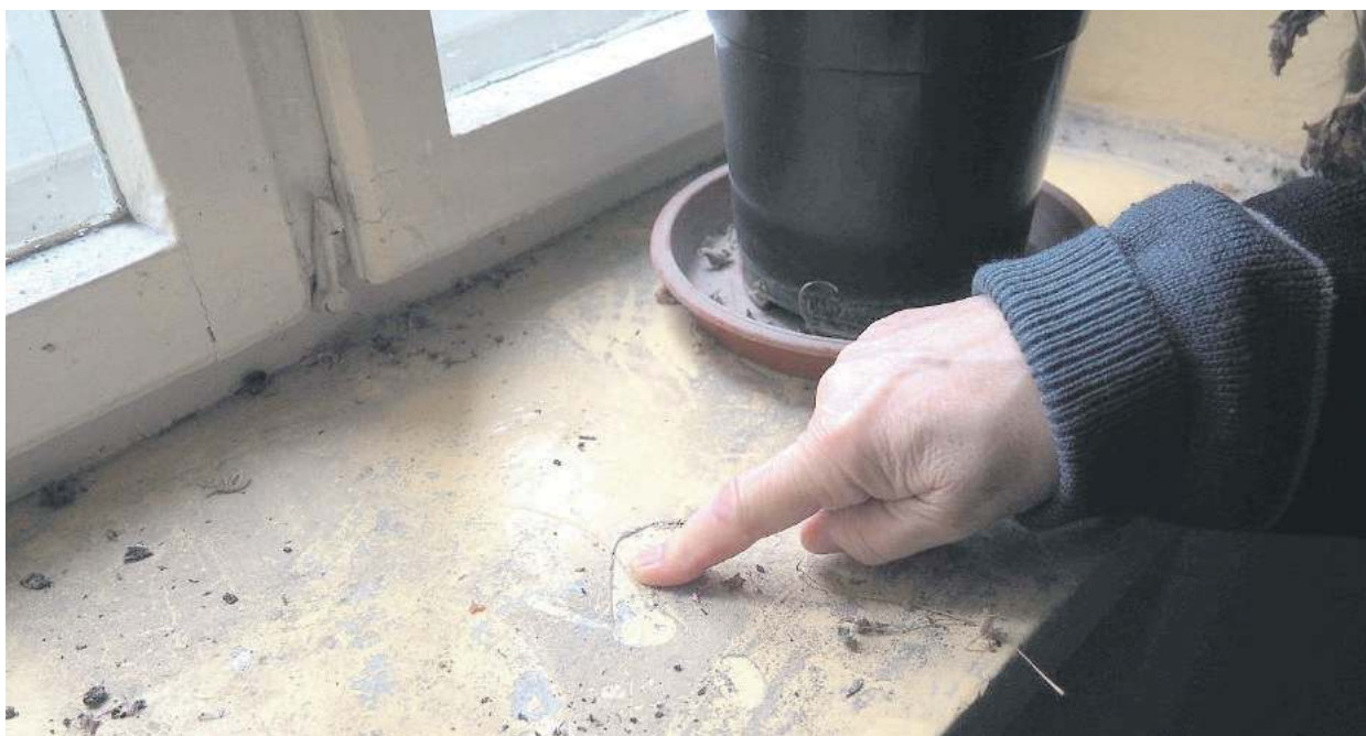
Kurz po remoncie na klatce schodowej
