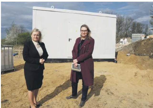
Plac budowy odwiedziła burmistrz Dorota Pawnuik (z lewej) oraz Anna Umińska-Woroniecka, prezes strześlińskiego Zakładu Wodociągów i Kanalizacji. Fot. Lech Pąchalski
