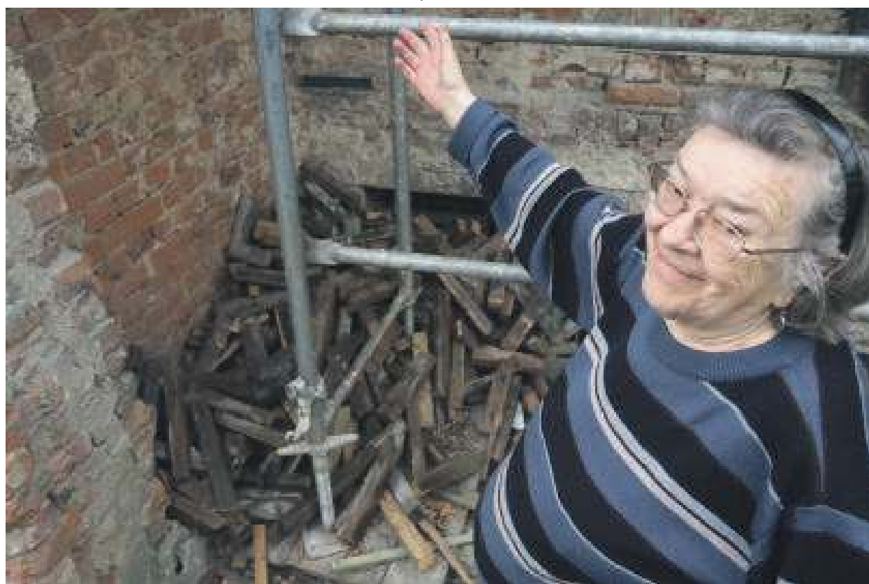
– Po remoncie pozostały rusztowania i inne rzeczy. Kiedy zostanie to posprzątane? – pyta Ewa Walczak-Rychlik
