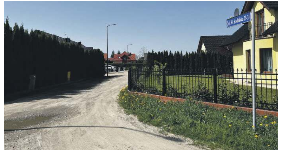
Firma Globistic z Pęcza będzie odpowiedzialna za remont ul. Kadłubka w Strzelinie
