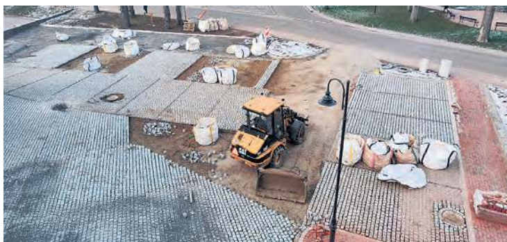
Widok na parking z boku budynku.
