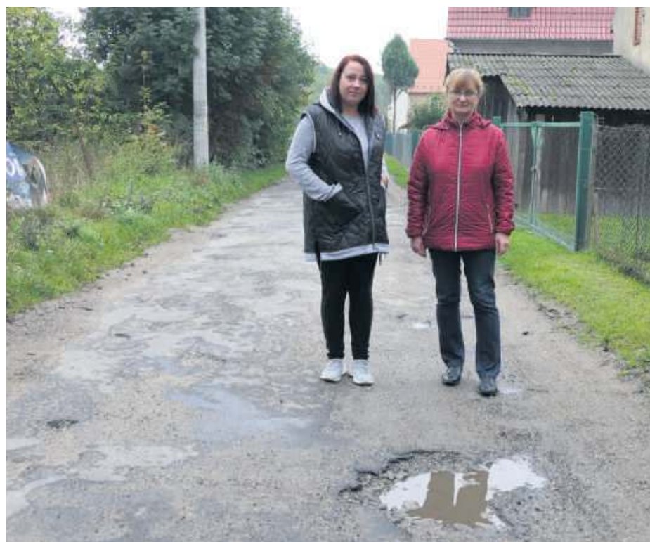
Sołtys Żeleznika, Bożena Matwijiszyn (z prawej), oraz jedna z mieszanek – Marlena Szczepańska, zwracają uwagę na zły stan drogi w tej wsi
