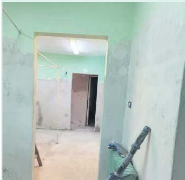
W Samodzielnym Publicznym Zespole Opieki Zdrowotnej w Przewornie trwają prace remontowe w pomieszczeniach oddziału rehabilitacji. Foto: UG Przeworno
