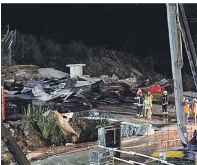
Pożar przy wlocie do tunelu.
