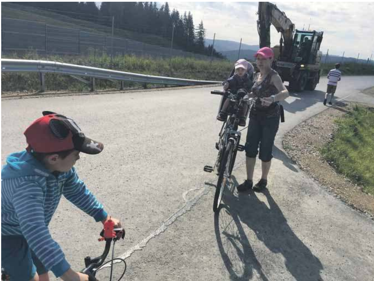
Życie na placu budowy, i tak od trzech lat.
