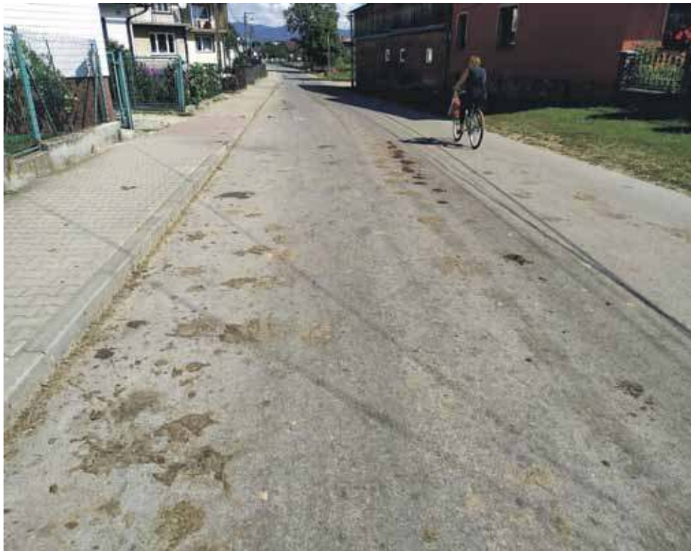
Tak wyglądają drogi w Krempachach po przepędzeniu krów.
