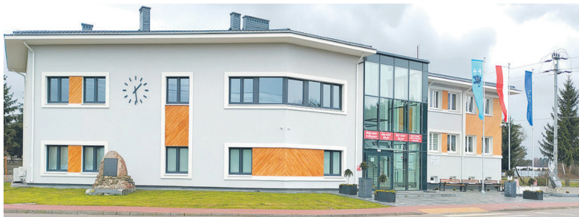
Nowy budynek urzędu gminy jest nowoczesny i funkcjonalny.
