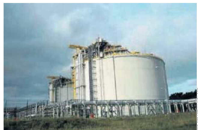
Nowy zbiornik, wraz z infrastrukturą towarzyszącą, jest kluczowym elementem II etapu rozbudowy Terminalu LNG
