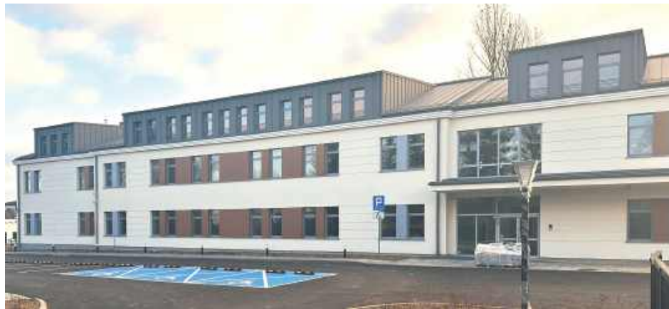
Nowy pawilon ZOL w Opolu Lubelskim. Trzykondygnacyjny obiekt zwiększył liczbę miejsc opieki długoterminowej z 25 do 96
