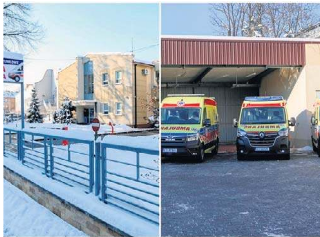
Powiat przymierza się właśnie do budowy nowej siedziby filii pogotowia w Wojniczu
