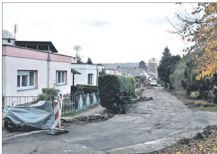
Prace na ul. Paderewskiego w Prudniku
