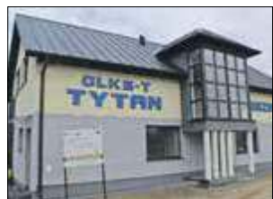
Budynek Tytanu Wisznice jest już przygotowywany do odbioru budowlanego
