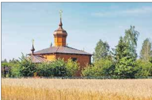
W Dobraticzach w ramach remontu wymieniono szalówkę zewnętrzną i wewnętrzną, wymieniono też konstrukcję dachu, dach pokryto blachą miedzianą, zrekonstruowano też sufit w prezbiterium i w nawie głównej
