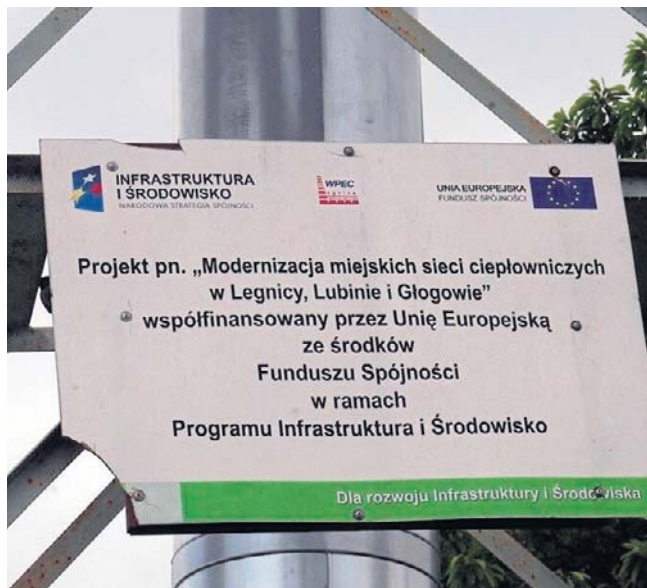
Nowa ciepłownia powstała z użyciem środków Unii
