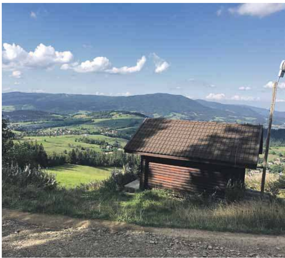
Górna stacja - tyle zostało z wyciągu na Maciejowej.
