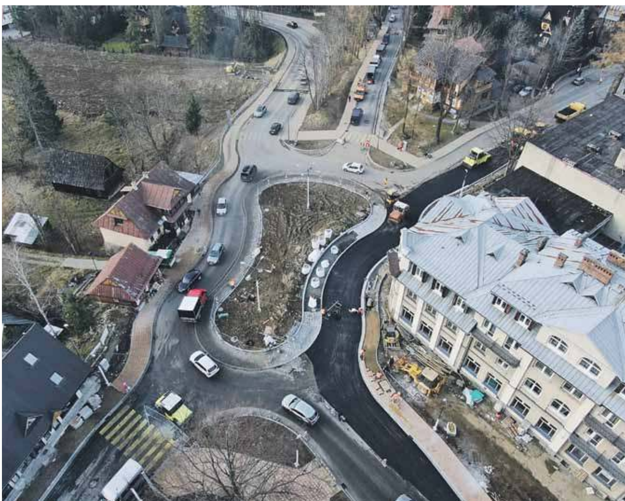
Nowe rondo na Bystrem prawie gotowe.
