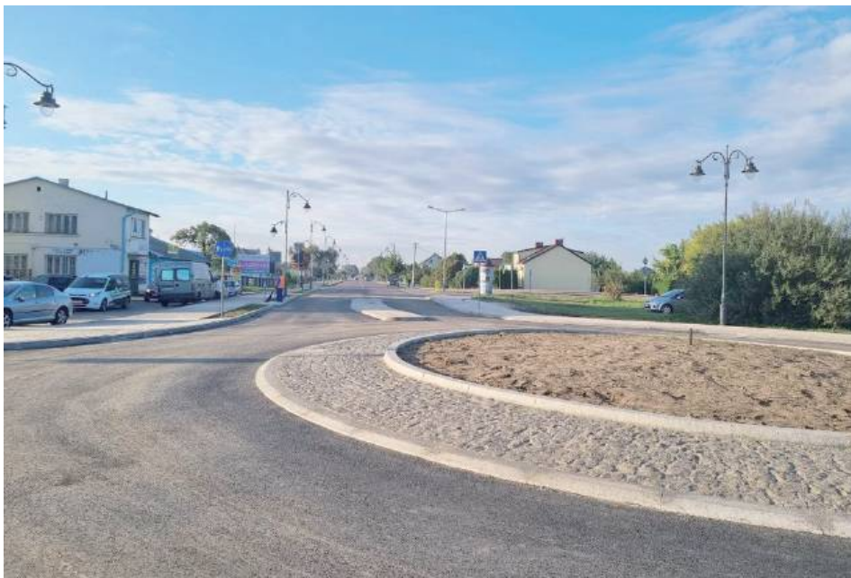
Ostateczny termin oddania ronda do użytku upłynął 15 października
