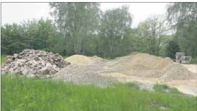
Teren parku wciąż jest placem budowy
