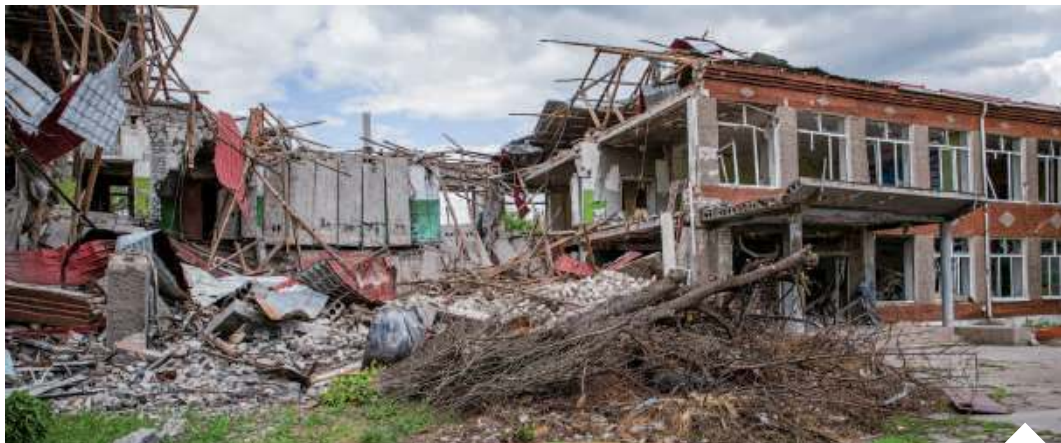
Zabudowa mieszkalna w Siewierodonecku na wschodzie Ukrainy została w 90 proc. zniszczona przez rosyjskie wojska
